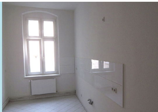
Et eksempel på et køkken før og efter renovering af ejendommen i Greifwalderstraße.
