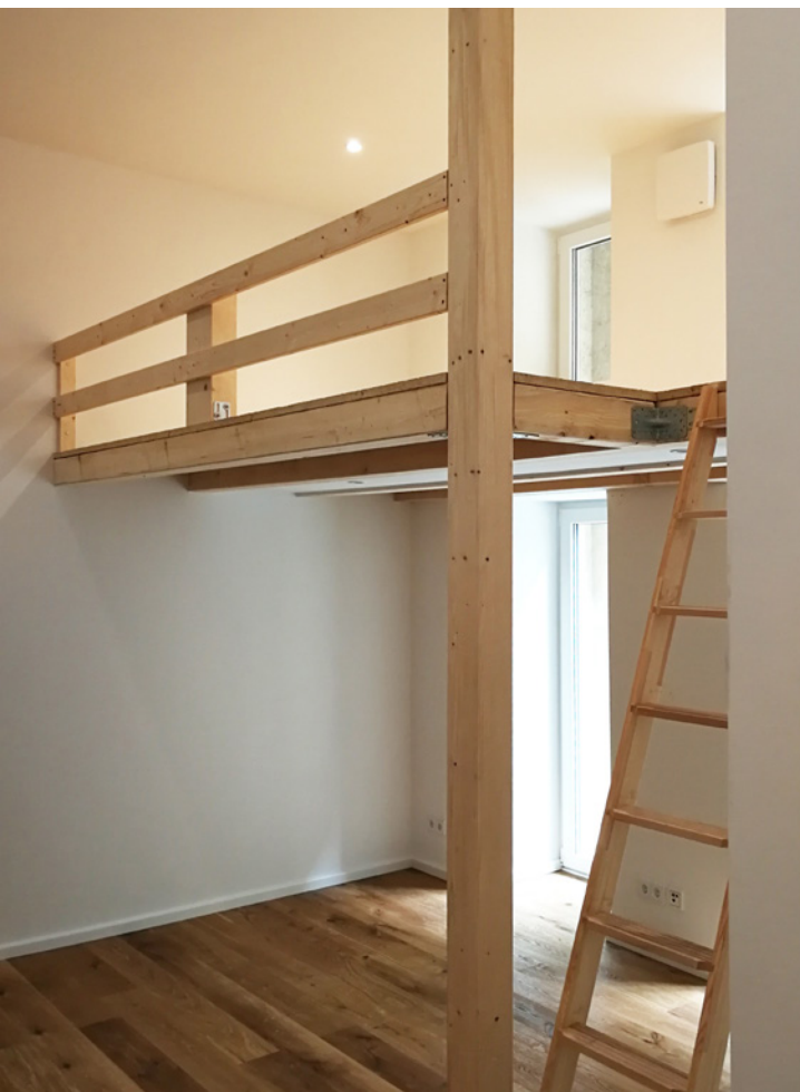
Loftshøjden i den gamle hestestald, er udnyttet til at bygge en hems i stuen.
