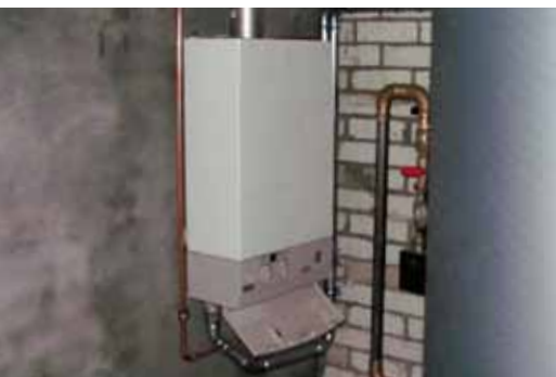
Varmtvands-installationer bliver trukket ud af lejlighederne og samlet i kælderen
