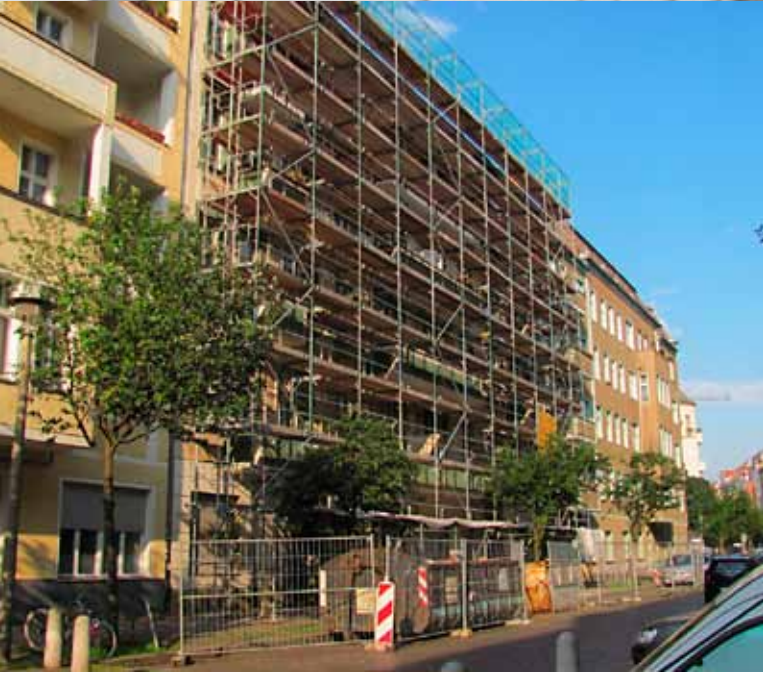
Facaderenovering og -isolering af Paul Robeson Straße, samt udbygning af taglejligheder.
