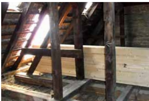
Materialer til udbygning af taglejligheder ligger klar
