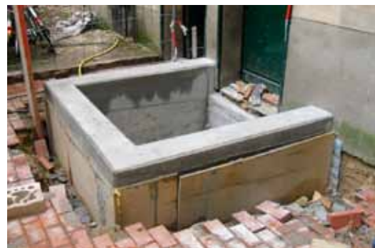
Fundament til elevator
